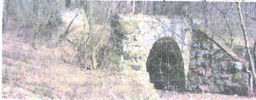
Рис. 13. Водопропускна споруда по трасі недобудованої залізниці у лісовому масиві біля Ходосівки і Круглика
