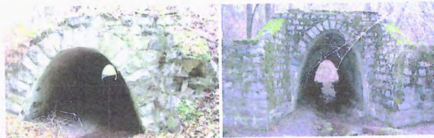
Рис. 14-15. Водопропускні споруди по трасі недобудованої залізниці у лісовому масиві біля Ходосівки і Круглика
